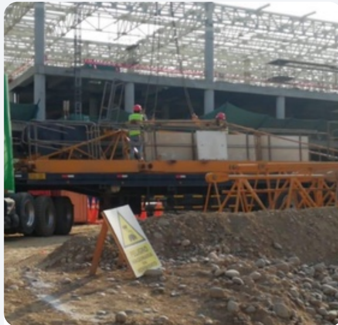
— OPERACIÓN EN OBRA
